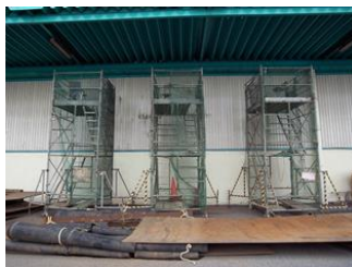
散水台 (改善前:屋根なし)
