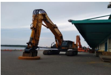
陸揚げ機械にエアコン装備
