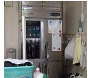
冷蔵庫の設置
