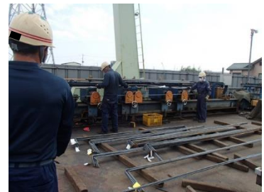
屋外作業現場
