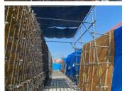
屋外作業場所へ日よけとなる遮光ネットを設置 [使用物品]遮光ネット、ワイヤー、カラビナ、ハト目、単管、杭、クランプ、トラロープ
