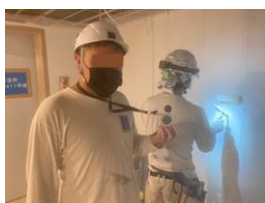
【写真4】作業場所ごとに WBGT 値を実測している様子
