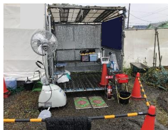
休憩場所(1間×1間)完成
