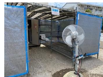
休憩場所(ミスト扇風機設置)
