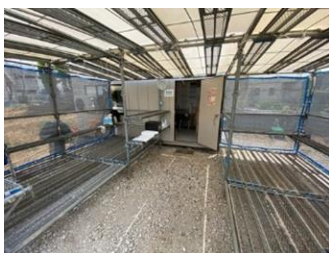
休憩場所(2間×3間)足場材のみ
