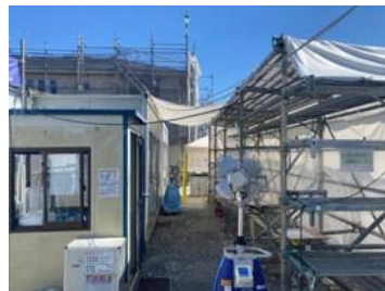
移動式のテントの設置
