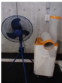
スポットクーラー・業務用扇風機の設置
