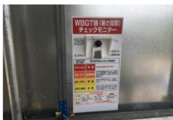
現場の養生用囲いに設置された WBGTチェックモニター
