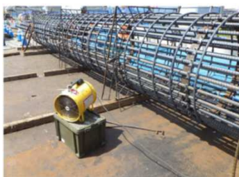
屋外の現場。下に鉄板があり 輻射熱が著しい
