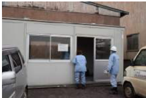
エアコン、冷蔵庫、給水機を 設置した工場建屋外にある 休憩用プレハブ
