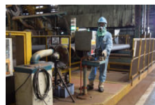
スポットクーラー(作業現場)
